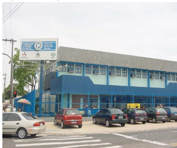
Figura 9: Fundação Alfredo da Mata – Manaus, Am
